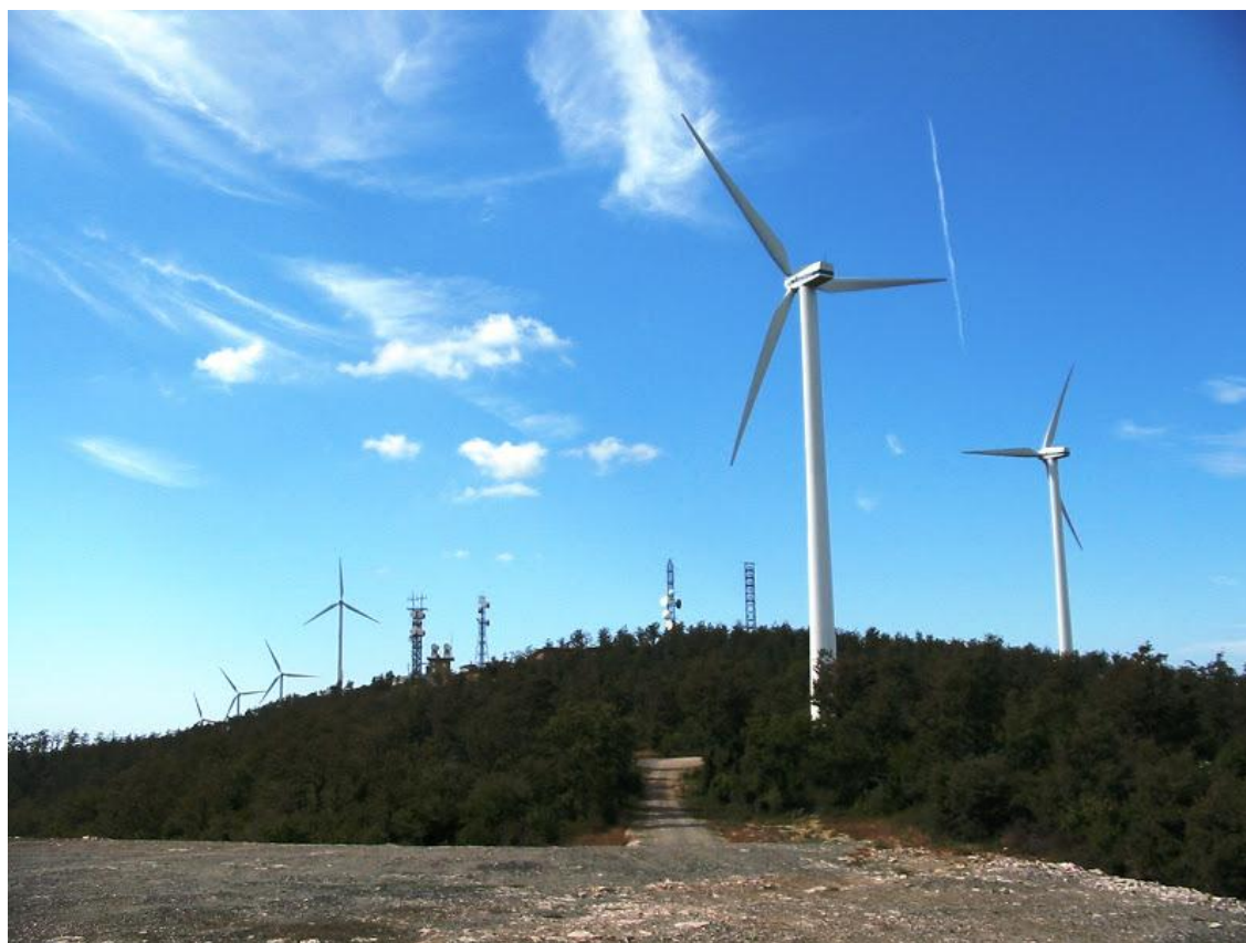
Gli impianti eolici del Monte Vaso
